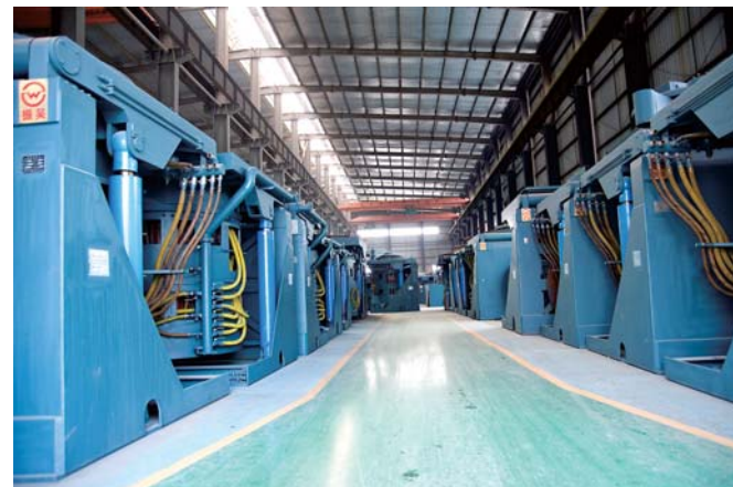
总装车间 Assembly Workshop
