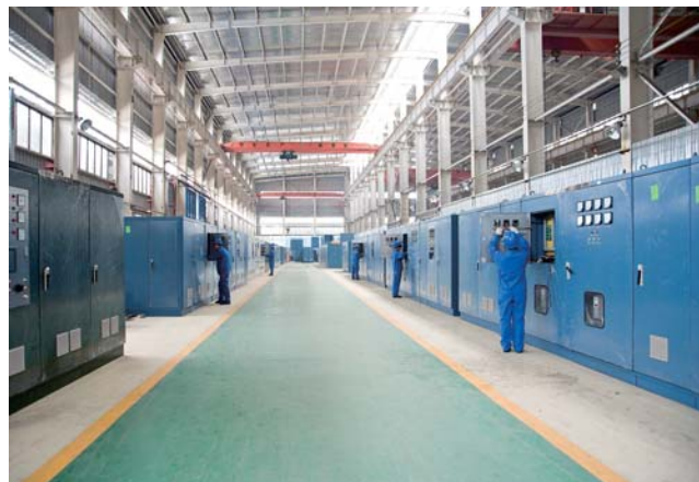
电气车间 Electrical Workshop
